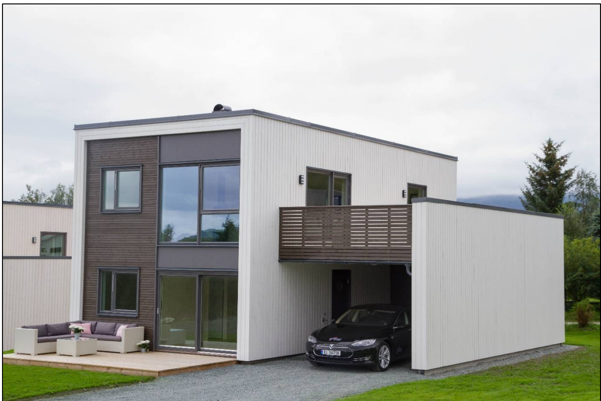
Figur 21 Bilde av en ferdig bygd Trend 2 bolig sett fra framsiden.
