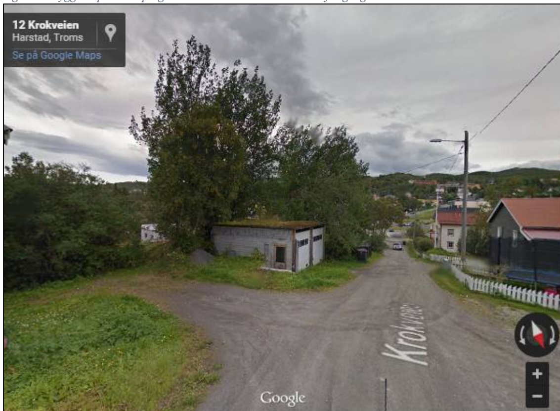
Figur 6 Eiendommen sett fra nord, eiendomsgrensen går på oversiden av garasjene. Bildet er hentet fra google streetview.
