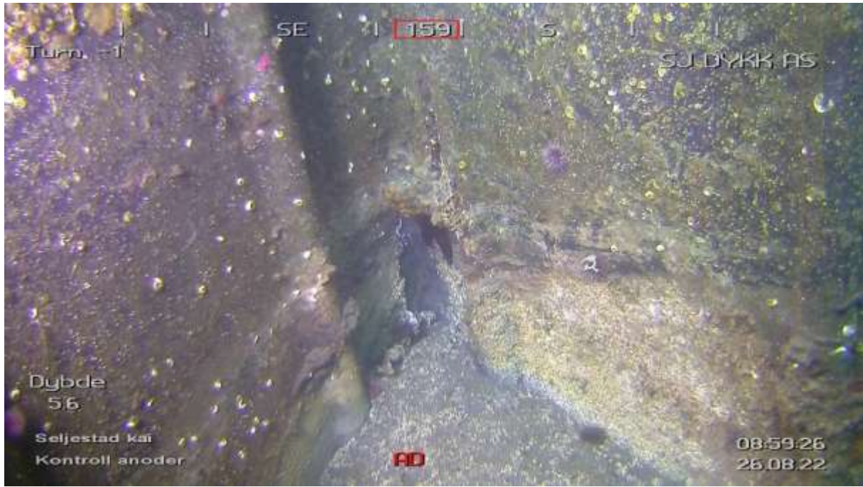
Figur 1 Overgang celle 2,5 - 2: Lite tildekningsområde rundt spuntlås
