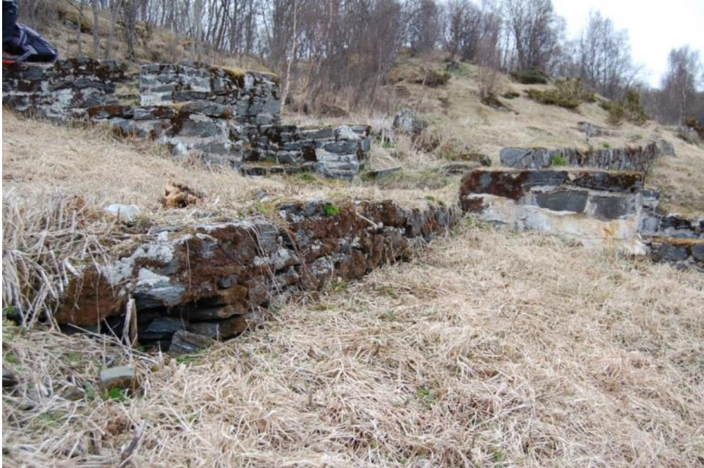
Figur 12 Støttemur, nr. 5, ligger vest for trapp, nr. 3.
