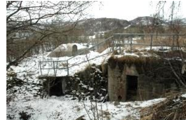
Inngang til bunker eller maskingeværstilling til høyre
