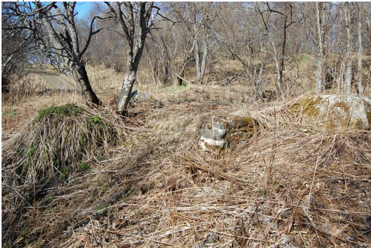
Figur 22 Trapp og støttemur nr. 13
