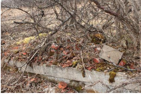
Figur 34. Sammenrast pipefundament. Foto: Gunhild Hovind, Hovind kulturminneforvaltning
