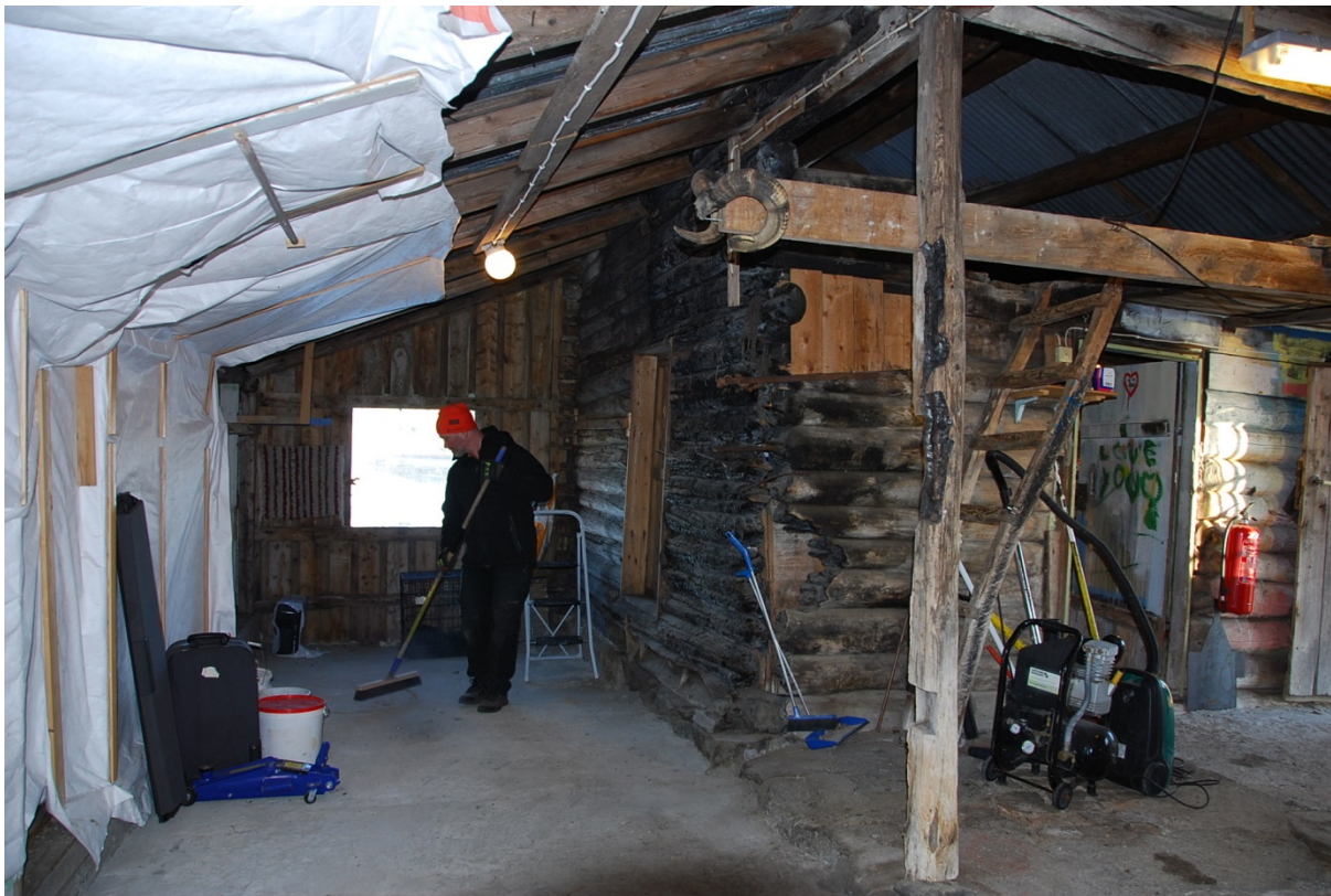
Mot nord. Her vises delen av tømmerveggen som har gamle brannskader. Bildet under sees mot øst, med litt av loftet som sees på venstre side.
