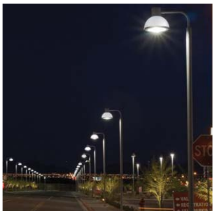
Armaturen har en svakt glødende kuppel som tydeliggjør gateløpet gjennom sentrum. Dette gir intuitiv navigering og reduserer kontrastforkjellen mellom lyskilden og nattehimmelen (minsker blending).
