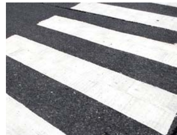
Asfalmaling i gangfelt
