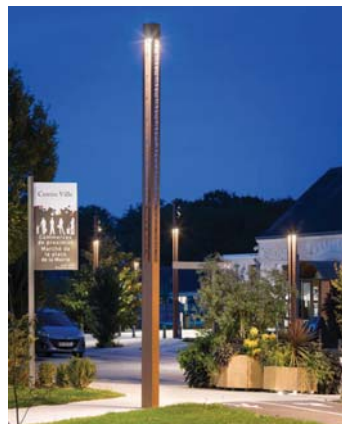
Eksempelarmatur Technilum Creille: Masten belyser seg selv og sine omgivelser. Lanterneeffekten masten skaper blir en ledelinje langs gangtraseen.
