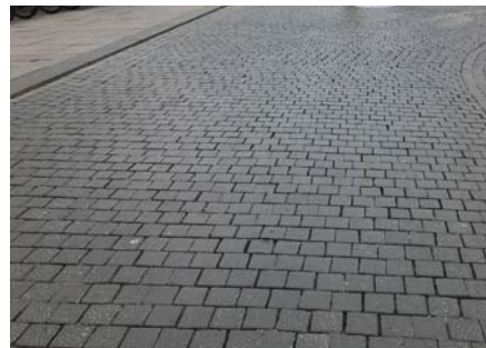
Smågatestein av mørk granitt med jevn overflate - flammet og grovpiket.
