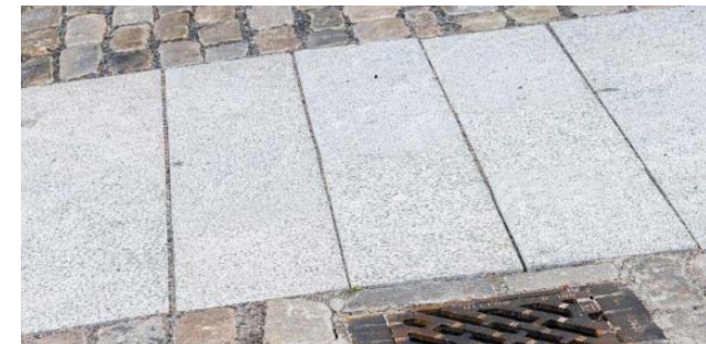
Brede kantbånd i lys granitt, jevn overflate, prikkhamret grad 2. Monteres i hele formater, slik at båndets bredde = 1500mm.
