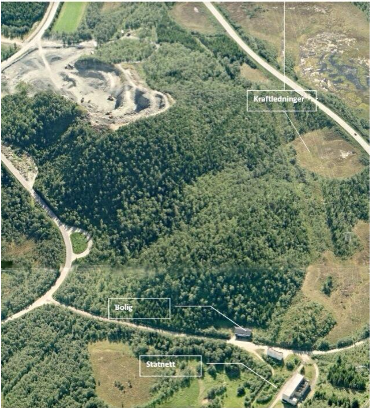
Bilde 2: Skråfoto av nærområdet, sett mot sør (Kilde: Gule sider)
