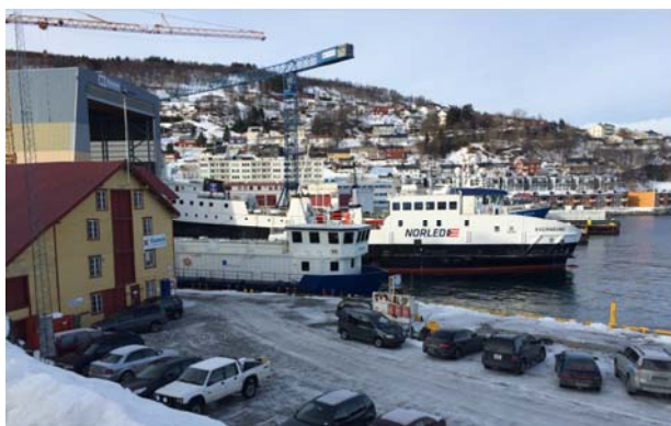
Hamek med del av verkstedbygget
