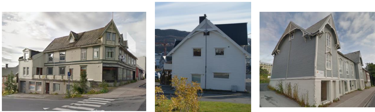
Figur 5. Typisk for sone 4 og speielt øvre dela av Storgt er samling av velholdte trehus fra tidlig 1900-tallet. Her tre bygg med typisk sveithusstil. (foto. Harstad kommune og Google street view)
