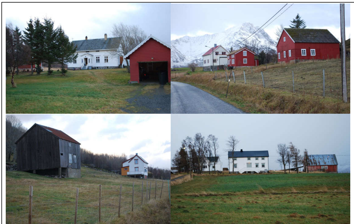
Verneverdige bygninger Vestnes og Tromsneset.
