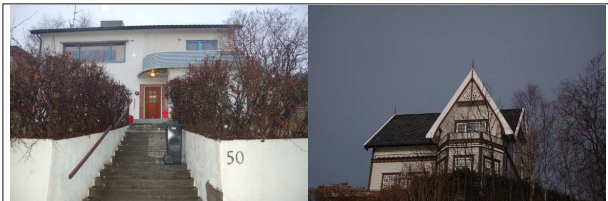
Funksjonalisme i Hålogalandsgate og sveitserstil i St.Olavs gate (foto: NIKU 2008)
