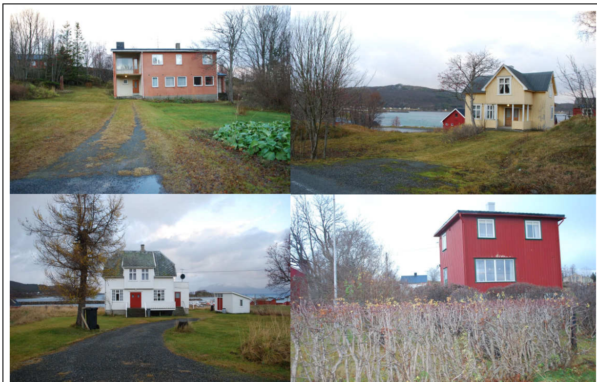
Eksempler på kulturhistorisk interessante enkeltbygninger Bjarkøy sentrum
