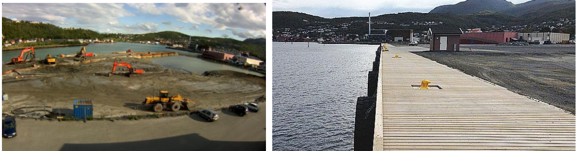
Fra oppfylling og tildekking av deponiet for forurenset sjøbunn. Ny kaipromenade lags spuntveggen på Seljestad. Foto: Kystverket
