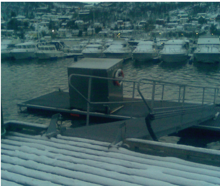
Figur 8 Foto av pumpehus på kai
