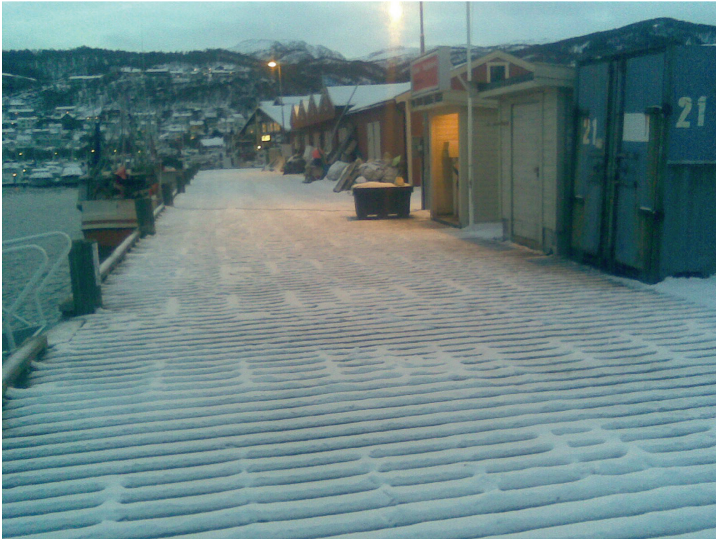
Figur 7 Foto av kai på område C. Dieselpumpe ses i opplyst skur midt på bildet.
