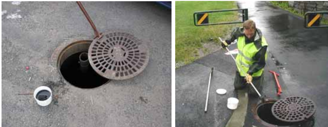
Figur 5. Kummene ble åpnet, og materialet ble hentet ut med en øseanretning i aluminium
