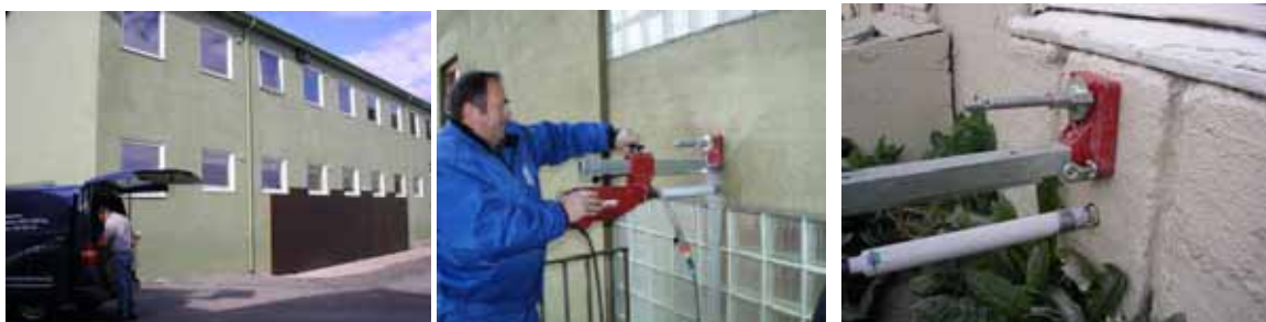
Figur 4. Prøvetaking av betongkjerne fra murfasader. T.v.: Seljestad skole, Harstad
